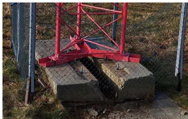
Рис. 2. Загальний вигляд надземної частини фундаменту
