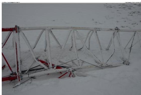
Рис. 7. Пошкоджена секція 6 від падіння на інший фрагмент щогли
