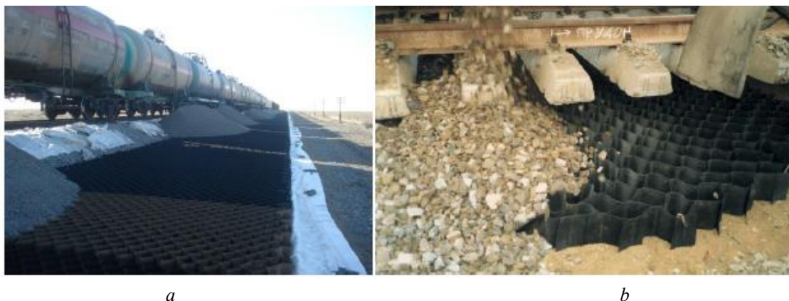
Рис. 2. Застосування об'ємних георешіток для підсилення та стабілізації земляного полотна: a – під час будівництва додаткових колій; b – в укріпленні наявних.
