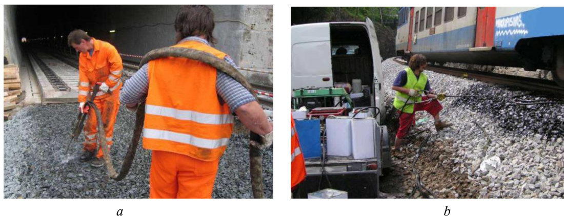
Рис. 3. Застосування поліуретанової композиції: a – виконання ділянки з перехідною жорсткістю за допомогою ін'єктування поліуретанової суміші; b – укріплення плеча баластної призми в кривих малого радіуса.
