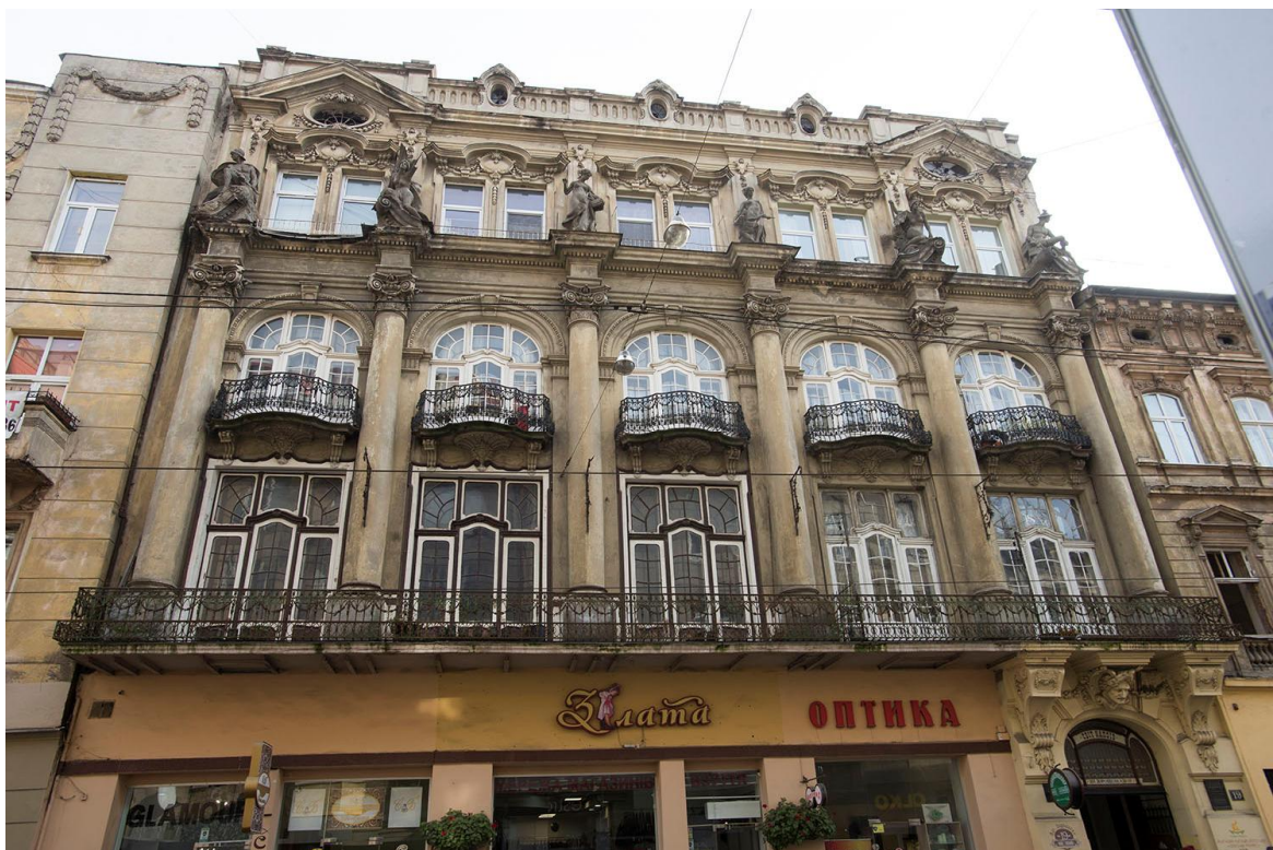
Рис. 1. Вигляд головного фасаду
