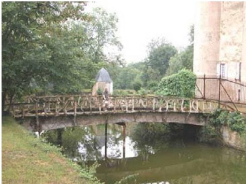
Рис. 6. Перший міст із залізобетону, у Шазеле, Франція, автор Жозеф Моньє, 1875 рік
