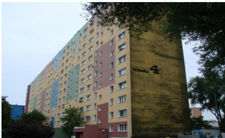
Rys. 8. Budynek wielkopłytowy po termomodernizacji
