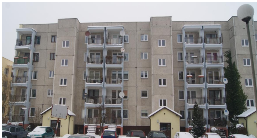
Rys. 2. Wygląd budynków budowanych w technologii prefabrykowanej
