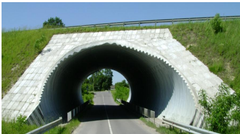
Рис. 2. Металева гофрована конструкція прогоном 12 м на обході м. Олеська у Львівській області
