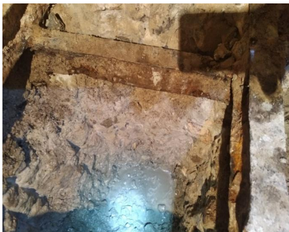
Рис. 2. Загальний вигляд армування залізобетонної монолітної фундаментної плити
