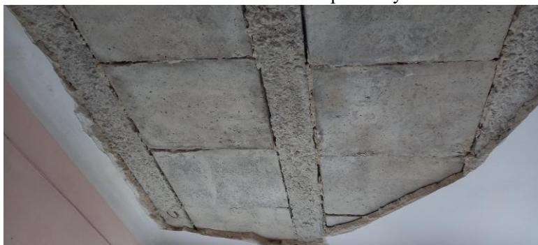
Рис. 6. Частина заміненого дерев'яного перекрыття на збірне залізобетонне між першим та другим поверхами
