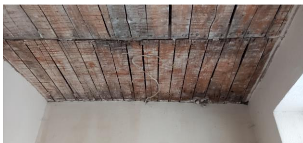
Рис. 7. Загальний вигляд перекрыття без штукатурного шару
