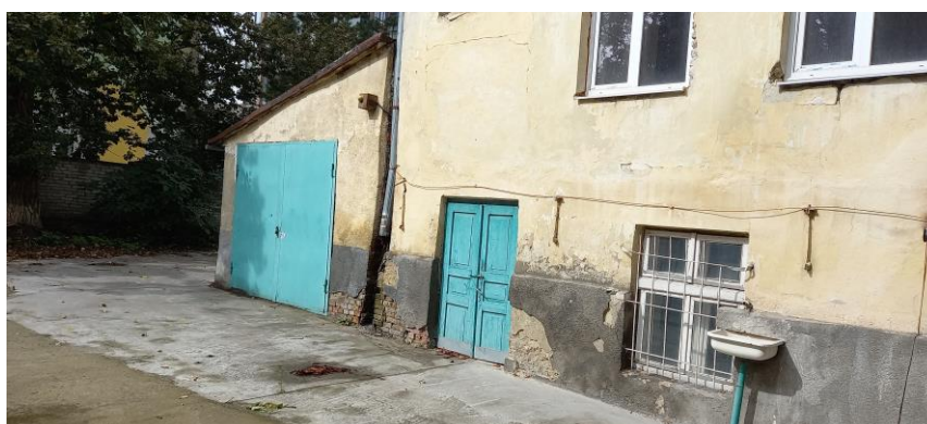
Рис. 2. Загальний вигляд будівлі гаража
