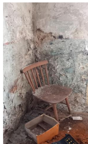
Рис. 4. Сліди вологості на стінах фундаментів; відпадання штукатурного шару; грибок та пліснява
