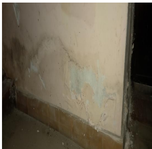
Рис. 4. Сліди вологості на стінах фундаментів; відпадання штукатурного шару; грибок та пліснява
