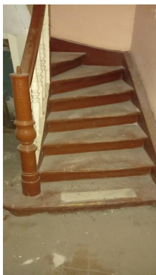
Рис. 10. Загальний вигляд службової (другої) сходової клітки, виконаної з дерев'яних елементів. Сходові перекриття оздоблені лакованими дерев'яними дошками, які надають сходовій клітці естетичного вигляду.
